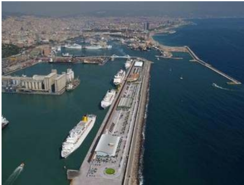
Figura 3: Terminales del puerto de Barcelona
