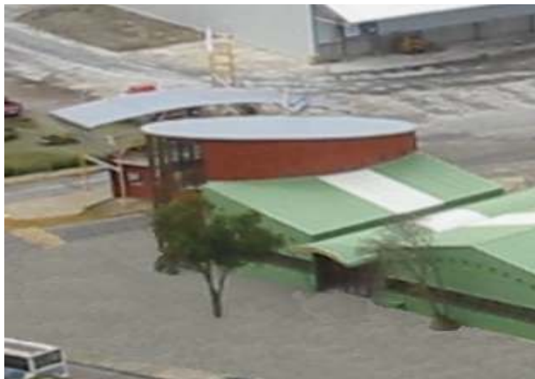
Figura 12: Vista superior del terminal de cruceros “Portal de la Patagonia”
